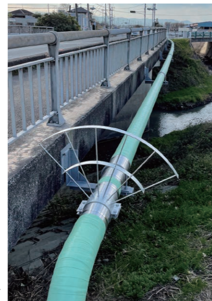
カーブを付けて ガス管設置する 高い施工技術を保有
