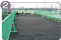
2 保護マットを敷きます。
