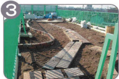
3 ルーフソイルが約10cm盛土され、庭の造園の骨格が出来てきます。
