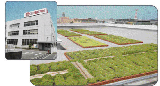
▲三浦印刷機 (船橋市)
